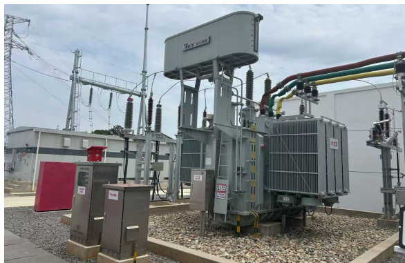
三宁磷石膏净化 110kV 变电站项目
